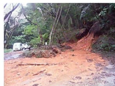
山腹斜面崩落
