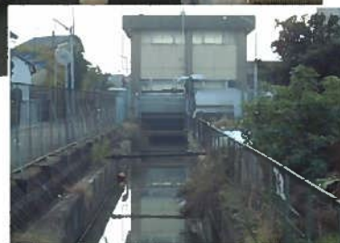
三ヶ月排水機場
