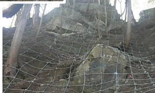
治山施設の整備後
