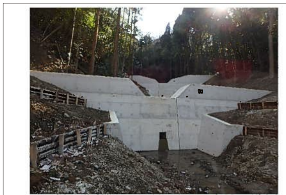
谷止工と床固工
