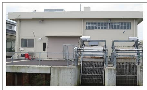
更新後の排水機場
