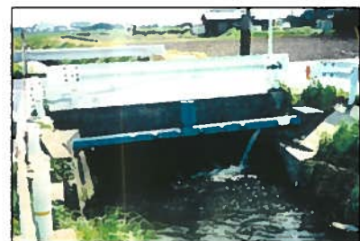
間々原堰掛りの新境川(整備前)
