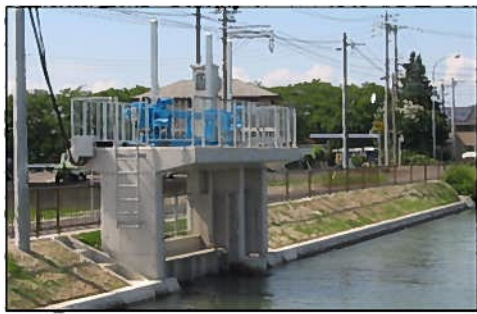
改修された合瀬川の荒井堰
