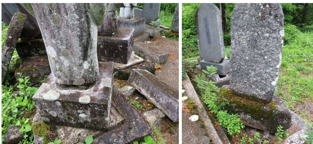
写真 2. 上から見て反時計回りに回転した霊神像（左）と霊神碑（右）。11 基中 1 基の霊神碑（左端）だけ倒れており、他は全て同じ方向に回転していた。
