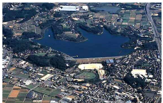
耐震対策を行う三好池(みよし市)
