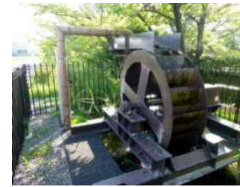
小水力発電システムの現地適応性技術の評価
