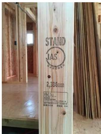
● 枠組壁工法構造用たて継ぎ材
