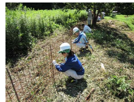
写真11 イノシシ柵の設置
