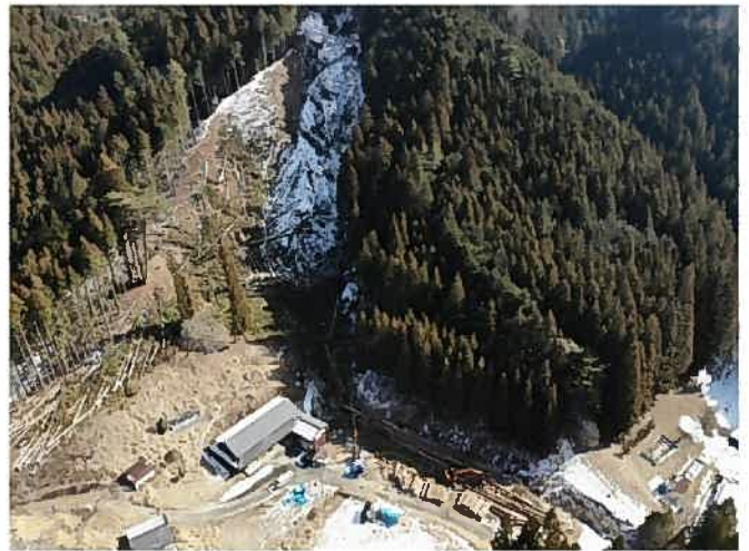
循環型林業・皆伐現場空撮
