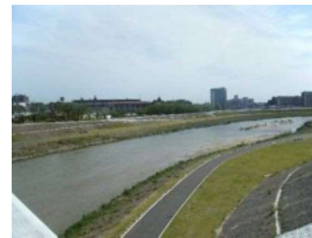
広田川：環境配慮型の護岸工
