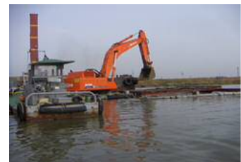
覆砂施工状況 (完了)
