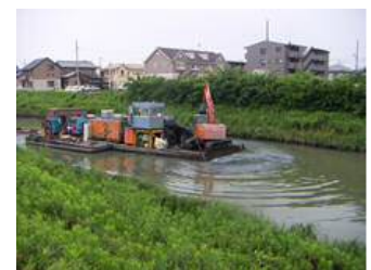
浚渫施工状況 (完了)
