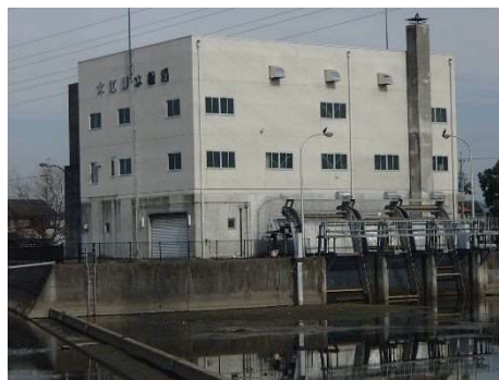
大江排水機場 建設(H3)
