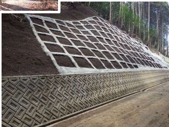
治山施設の整備状況（瀬戸市）
