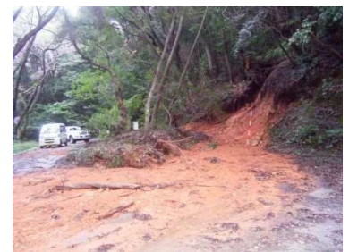
山腹斜面崩落
