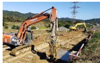
土質改良によるため池の耐震化工事
