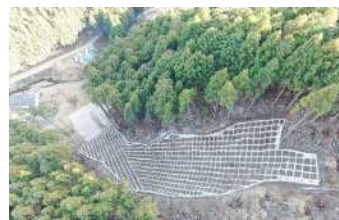
治山施設による山地災害地の復旧
