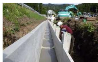
農業用排水路の整備
