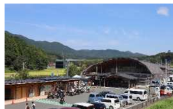
道の駅もっくる新城 (地域拠点施設)
