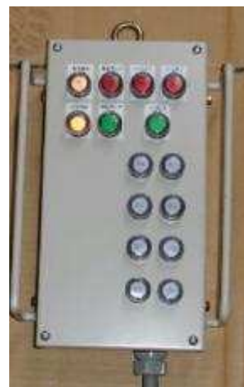
シールドジャッキ 操作装置
