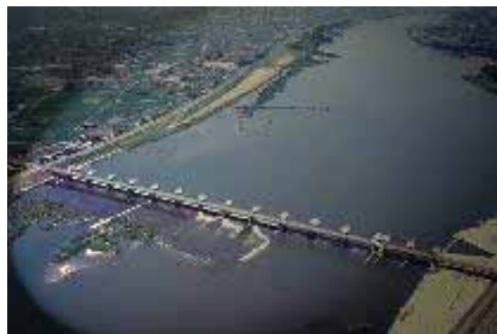
木曾川用水取水口（木曾川大堰）
