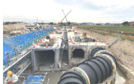
耐震対策を行う明治用水(豊田市)
