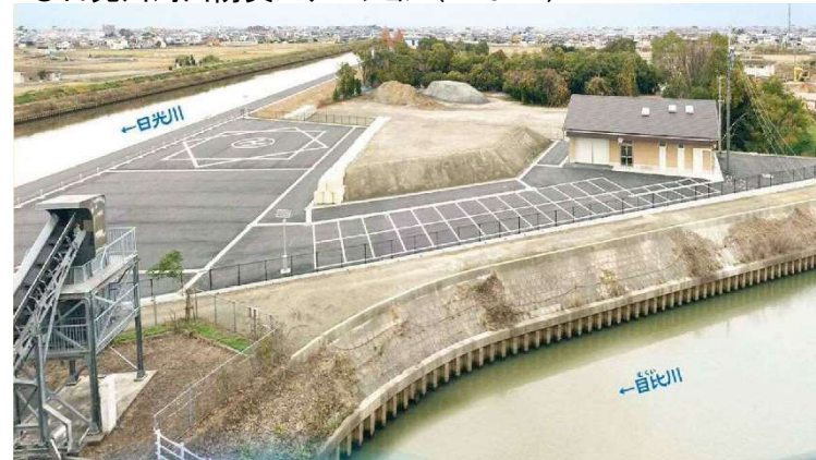
● 日光川 国道1号日光大橋 (H30.8)
