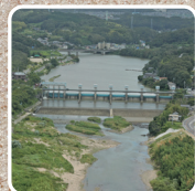
■明治用水頭首工(豊田市)
