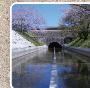
■牟呂松原幹線の第1号樋管(新城市)
