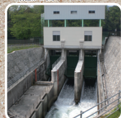
■兼山取水口(岐阜県八百津町)
