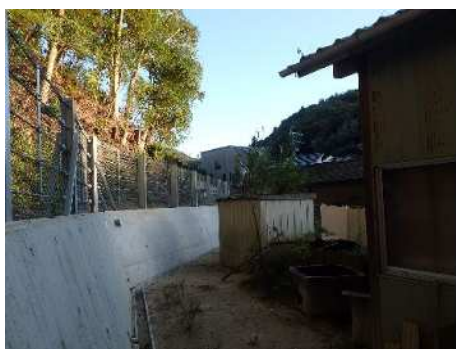
土留工（瀬戸市）
