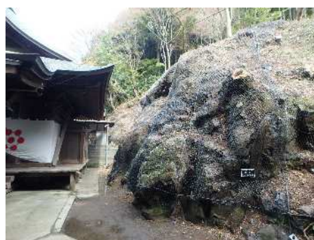
ロープ伏工（春日井市）
