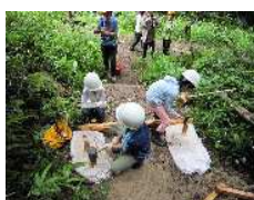
写真9 むさびっ子の森開拓団による階段補修
