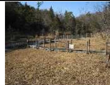
写真4 屋戸湿地の歩道と柵の改修
