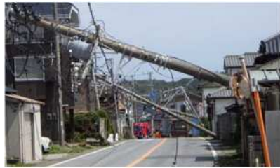
▲写真 2019年台風15号による電柱の倒壊状況(千葉県館山市船形)(出展：国土交通省HP)
