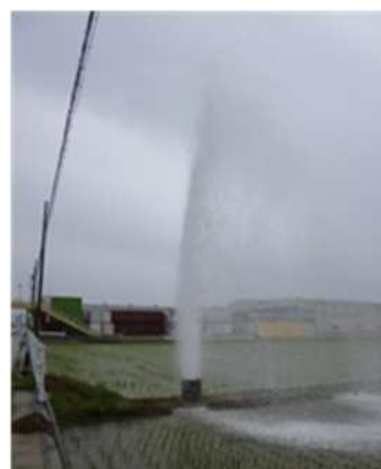
【老朽化した管の破損により漏水している農業用水施設(弥富市)】
