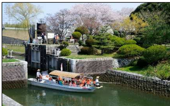
【船頭平閘門(愛西市)】
