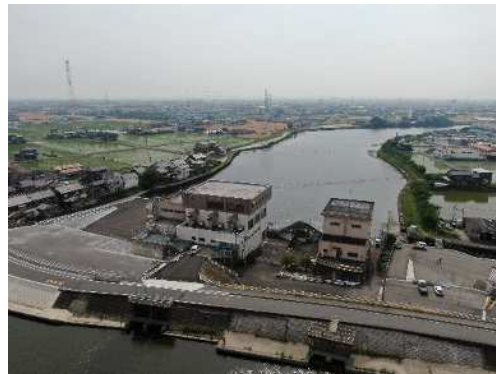
【善太排水機場(蟹江町)】
