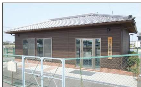
【大宝排水機場保存館(飛島村)】
