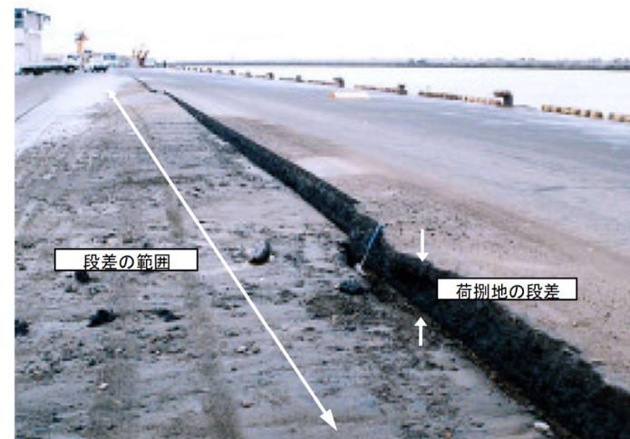
参考写真② 荷捌き地の段差
