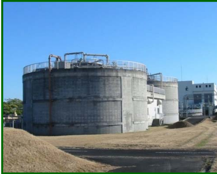
PFI 事業によるバイオガス発電 (豊川浄化センター)
