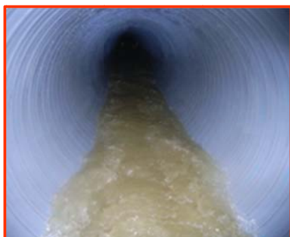
管路施設の耐震化・長寿命化 (豊川流域下水道 管更生)
