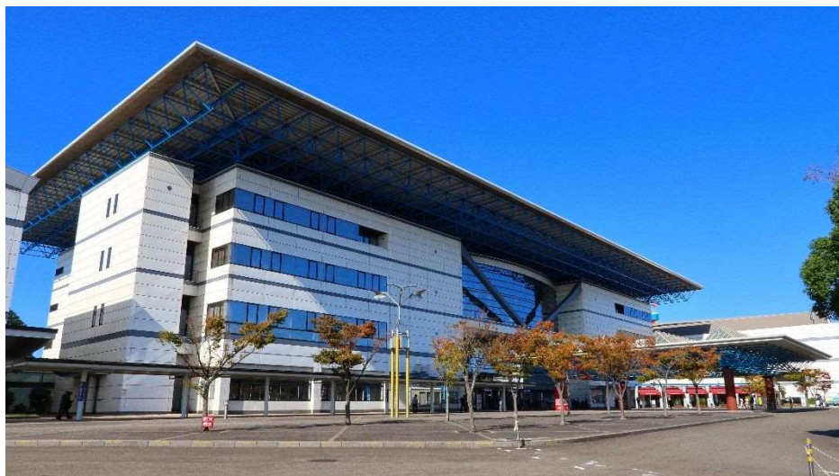
図表 名古屋市国際展示場（交流センター側） 外観
