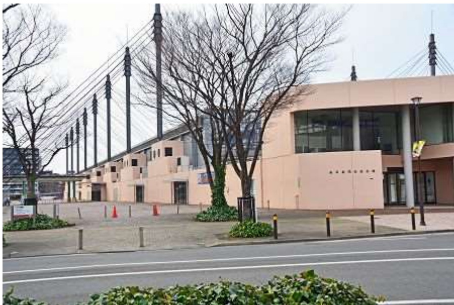
図表 西日本総合展示場本館 外観
