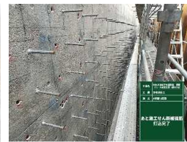
矢作川浄化センター 管廊の鉄筋補強
