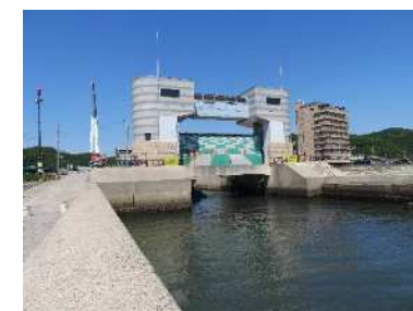
山海川樋門(南知多町)
