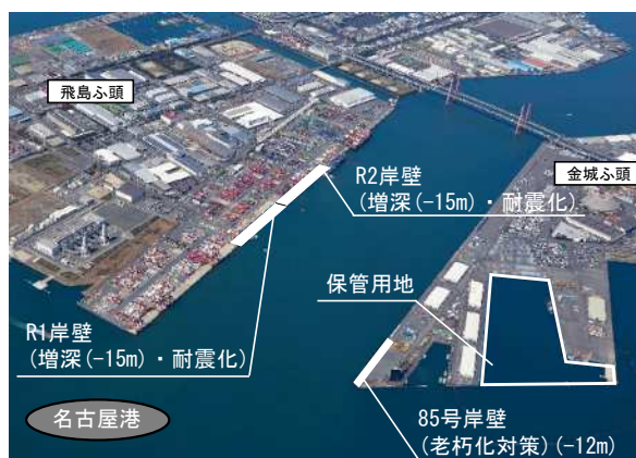
▲名古屋港の耐震岸壁等の整備
