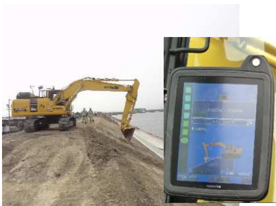
▲ICT建設機械による施工
