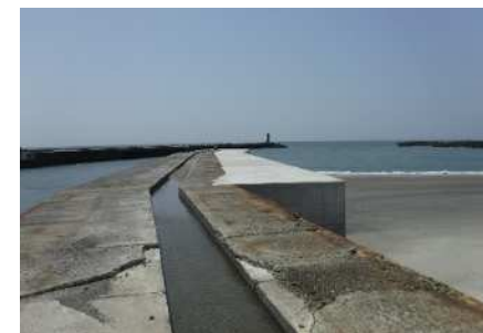
赤羽根漁港 防波堤(田原市)
