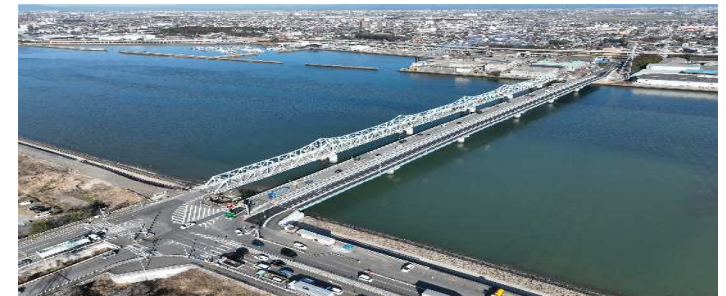
(国)247号 衣浦大橋左折専用橋(高浜市・半田市)
