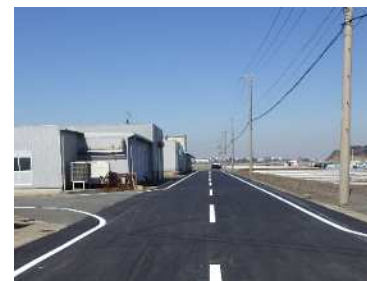
篠島漁港 舗装補修 (南知多町)
