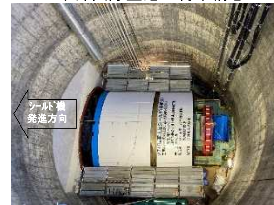
▲二級河川柳生川(豊橋市) 地下河川(発進立坑)の整備
