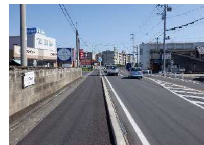
(一)西萩原北方線(一宮市) 歩道設置
