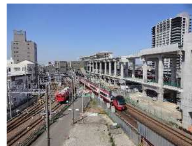
知立駅付近連続立体交差事業
