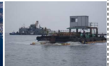
覆砂の作業状況
