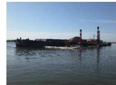
一色漁港 泊地浚渫 (西尾市)
