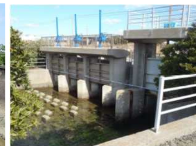
紺屋川樋門(田原市)
