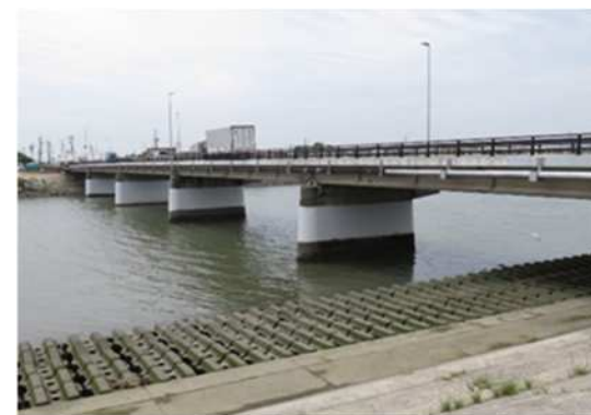
▲前芝大橋(豊橋市)の耐震補強
