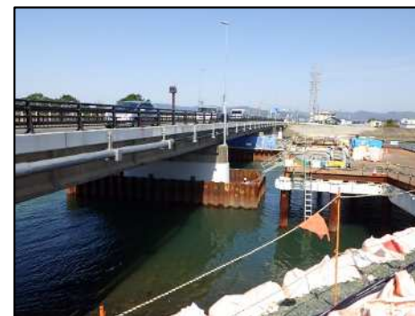
(国)23号 前芝大橋(豊橋市) 橋脚耐震補強工事
