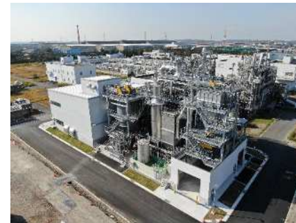
衣浦西部浄化センター 共同汚泥処理施設 (半田市)
