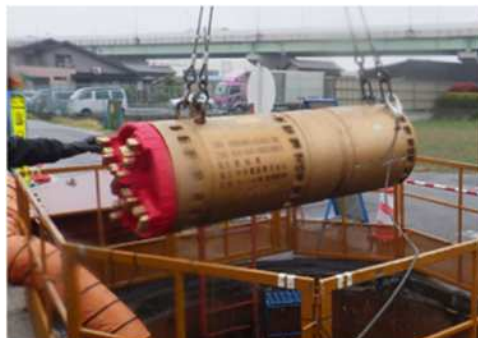
新川西部 流域下水道 (清須市) 管渠整備
