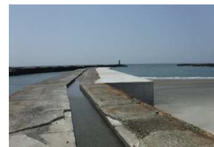
赤羽根漁港 防波堤 (田原市)
