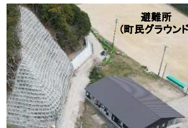
内海防災センター
