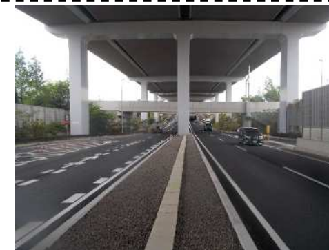
(主)名古屋岡崎線 中田工区 (豊田市)
