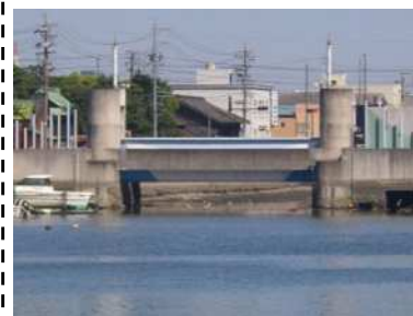
大浜漁港海岸水門(碧南市)
