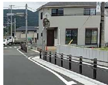
(一)小松原二川停車場線 防護柵設置
