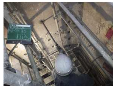
矢作川浄化センター 揚水施設の鉄筋補強
