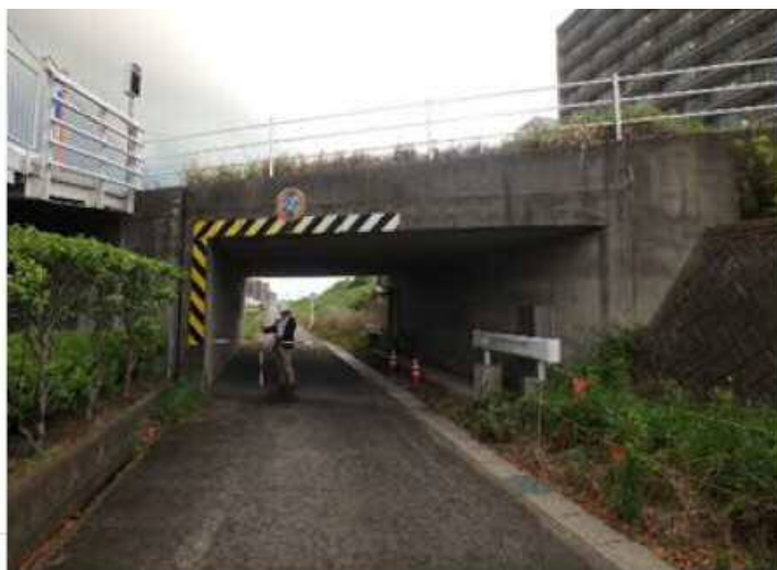
写真⑫ 幅6.0m, 高さ3.0m, 盛土比高4.0m
