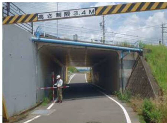
写真⑬ 幅6.0m, 高さ3.8m, 盛土比高4.4m
