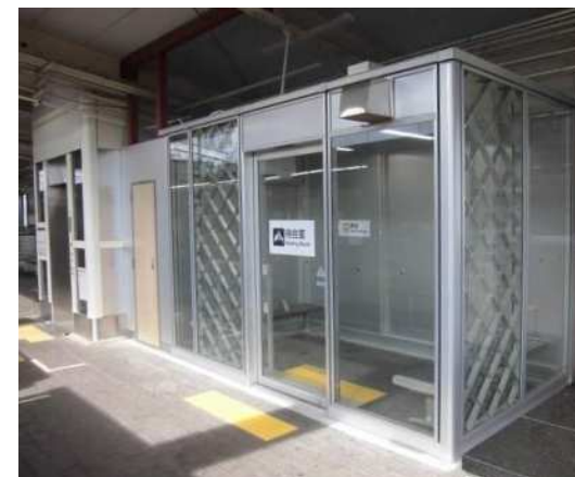
地下鉄藤が丘駅のホームに冷房付きの待合室を整備 <供用開始: 令和5年6月30日>
