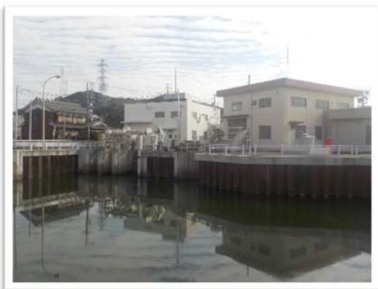
基幹的排水機場の更新(外観)
