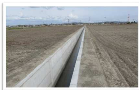
生産基盤整備(排水路改修と大区画化)
