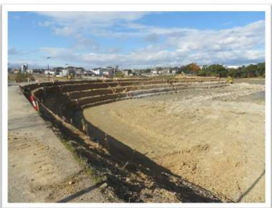
防災重点ため池の耐震化
