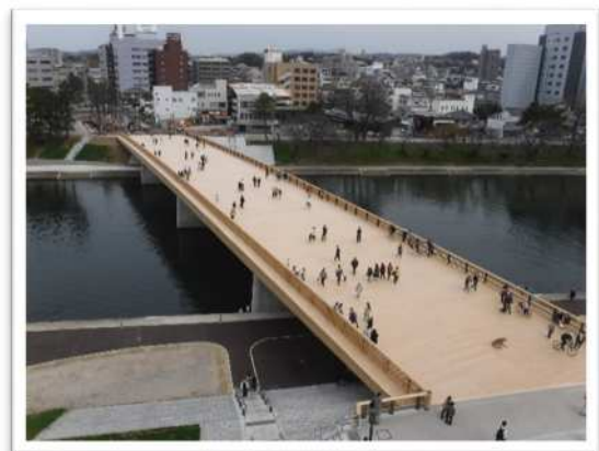
木材利用の一例（岡崎市桜城橋）
