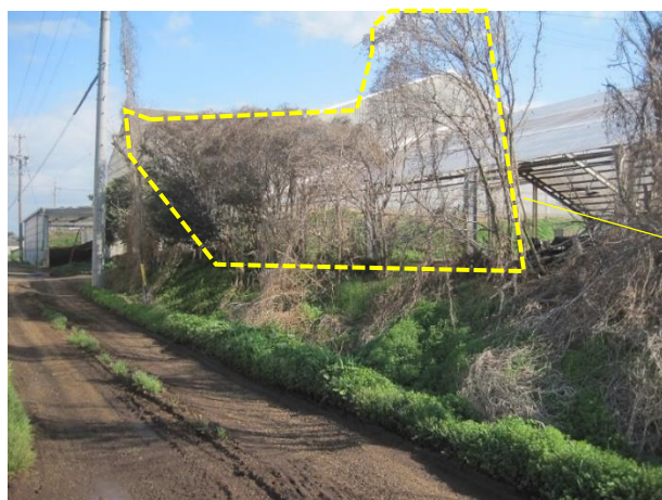
乾燥ハウス側面 生垣は発生ガスにより枯死の可能性
