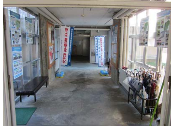
11/17 新設設楽総合庁舎
