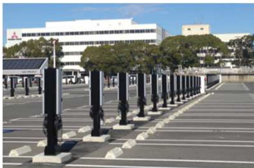
三菱自動車工業(株)岡崎製作所の設置風景
