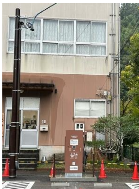
2024 年 12 月に設置した足助支所の急速充電器
