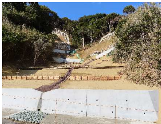
【治山施設（土留工）】
