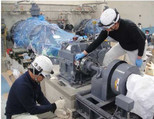
【整備中の梅敷排水機場】
