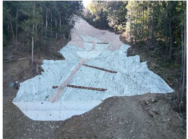
【山地災害からの復旧を図る治山施設】
