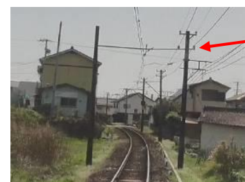
【渥美線】木製電柱のコンクリート化
