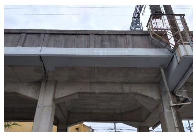
橋梁修繕（剥落防止）
