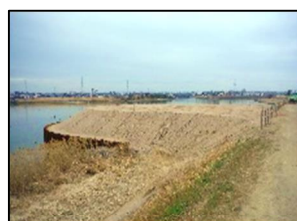
竜灯の岬(工事中)
