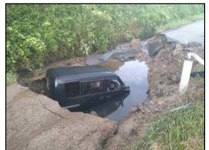
矢作川総合南部施設 (南部幹線水路の漏水)
