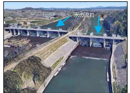
矢作川用水施設 (吉良・古川頭首工)
