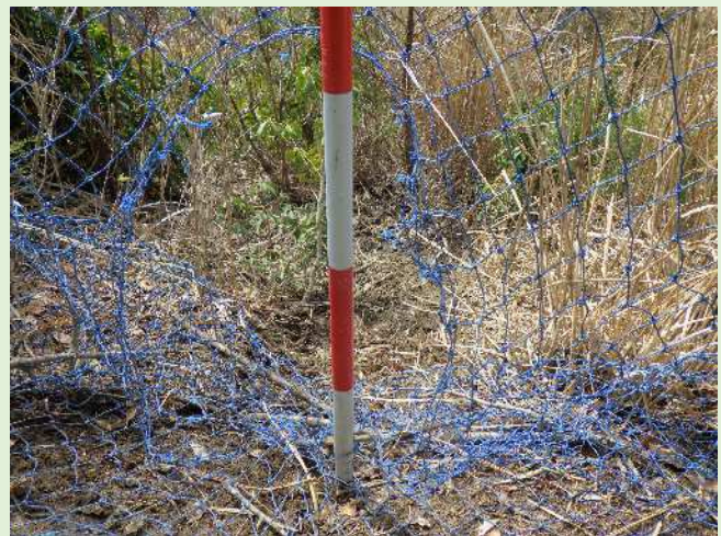
獣害防止柵の破損状況
