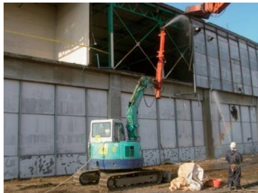
湿潤化の例(散水)
