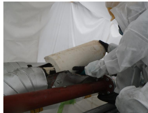
作業の状況(養生内で湿潤化後手作業で除去)
