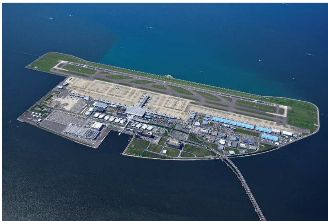
図表 中部国際空港全景
