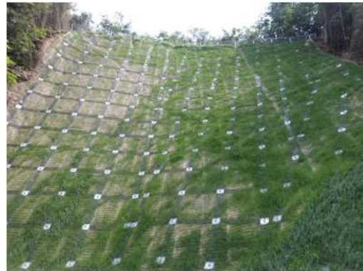
写真2 補強土工（ジオベルトプラス）
