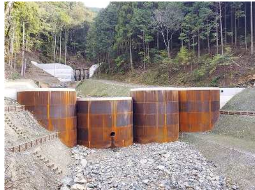
写真4 谷止工（鋼板セル）
