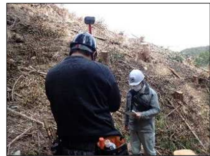
GNSSを活用した検査状況
