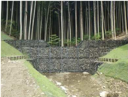
写真3 谷止工（鋼製自在枠）
