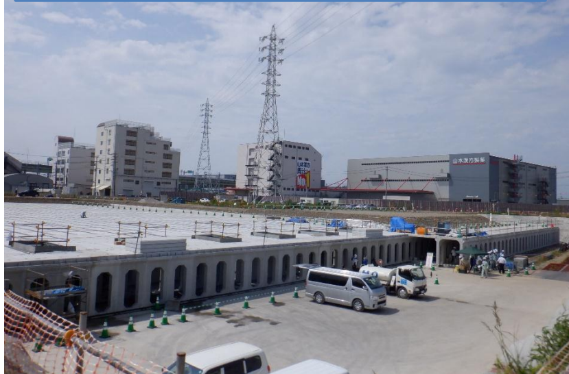
2025年10月 調整池本体完成、埋戻し開始
