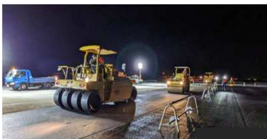
上層路盤のアスファルト舗装転圧
