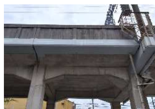
橋梁修繕（剥落防止）
