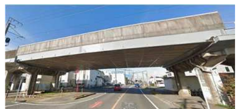
橋梁耐震対策
