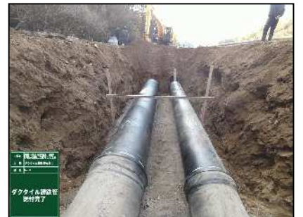
矢作川総合南部地区 土地改良施設突発事故復旧事業
