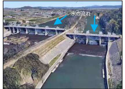
矢作川用水施設 (吉良・古川頭首工)
