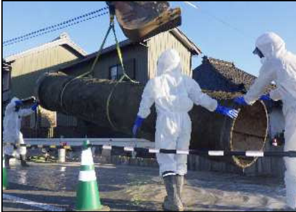
木曽川用水濃尾第二施設改築 (石綿セメント管の撤去)
