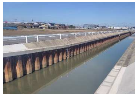
【排水路の改修】（弥富市）
