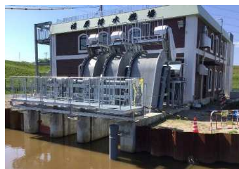
【排水機場の整備】（愛西市）
