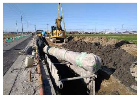
【石綿セメント管の撤去】(弥富市)
