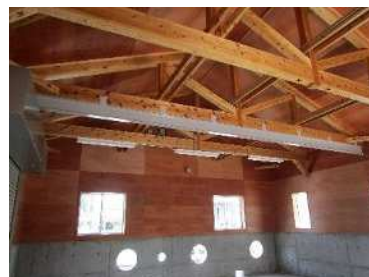
県産木材による用水機場の木造化
