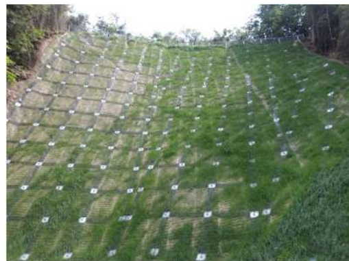
写真 2 補強土工（ジオベルトプラス）
