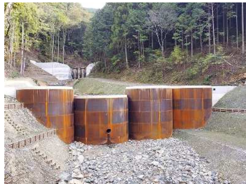
写真 4 谷止工（鋼板セル）
