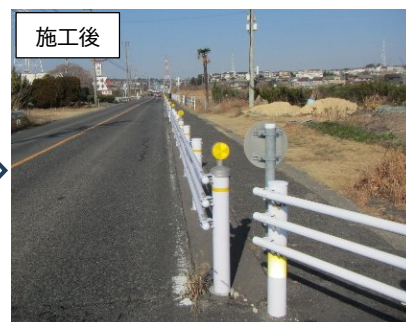
(一)浅田名古屋線(日進市) 防護柵設置工事
