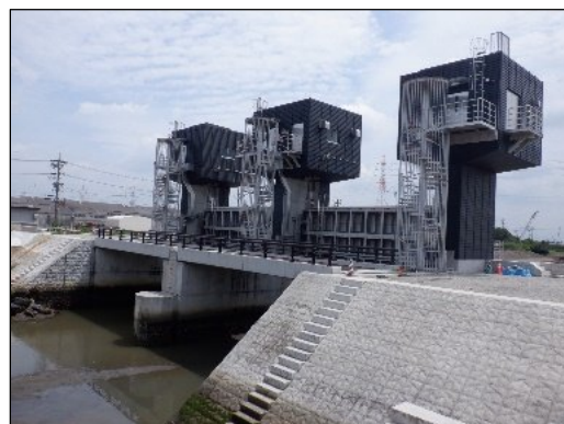
神戸川水門(半田市) 耐震化(改築)
