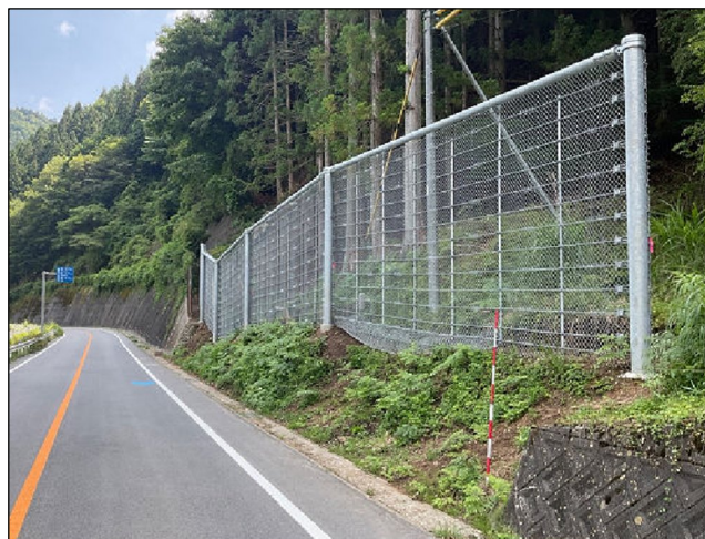
(国)151号(豊根村) 落石防護柵の整備
