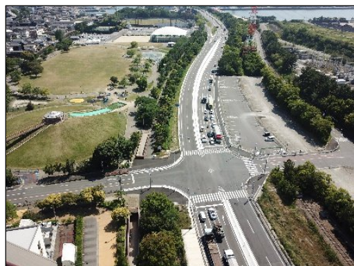
(国)247号 碧南拡幅(碧南市) (2025年12月 L=1.2km供用)
