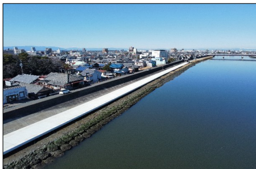
一級河川 新川(名古屋市中川区) 堤防耐震化
