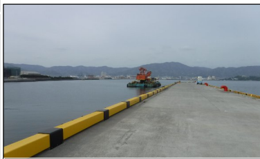
三河港蒲郡地区 岸壁(蒲郡市)
