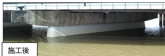
(一)碧南半田常滑線東雲橋(半田市) 橋脚巻立て
