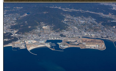
大塚地区 深堀れ跡の埋戻し・覆砂(蒲郡市)
