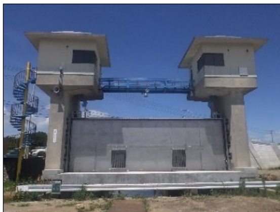
池尻川水門(田原市) 老朽化対策(扉体・開閉器の更新)
