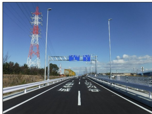
(国)247号 碧南高浜拡幅(碧南市・高浜市) (2025年5月 L=2.0km供用)
