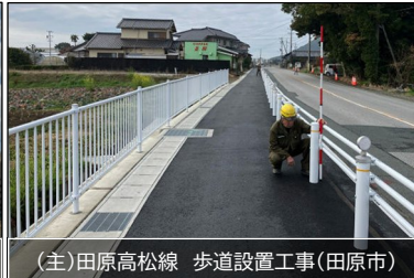
(主)田原高松線 歩道設置工事(田原市)
