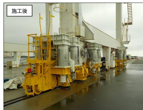
三河港神野地区(豊橋市) L大型荷役機械耐震化(2021年度完了)
