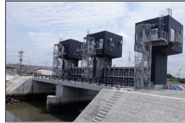
神戸川水門改築(半田市)
