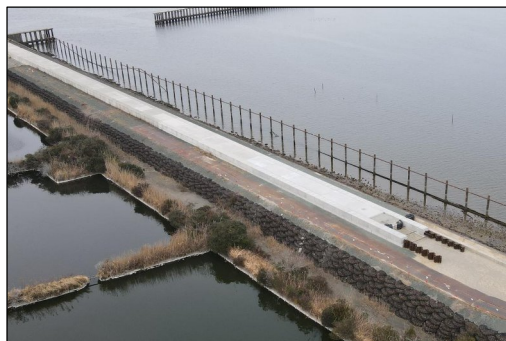
豊橋海岸(豊橋市) 堤防耐震化
