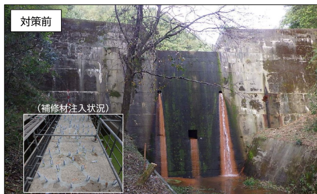
木瀬川右支川堰堤（豊田市）：堰堤のひび割れ補修
