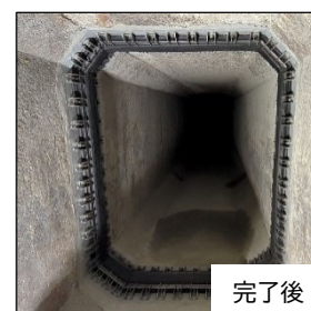
矢作川浄化センター(西尾市) 流入渠の継手耐震化
