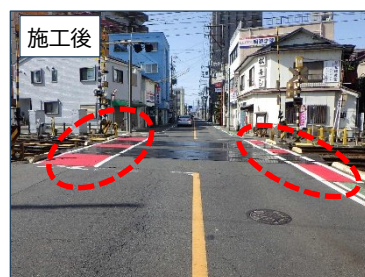
(一)江南木曽川線 カラー舗装等による速効対策
