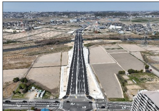
名古屋岡崎線(豊明・刈谷工区)(豊明市・刈谷市) L=0.8km供用(2026年3月)
