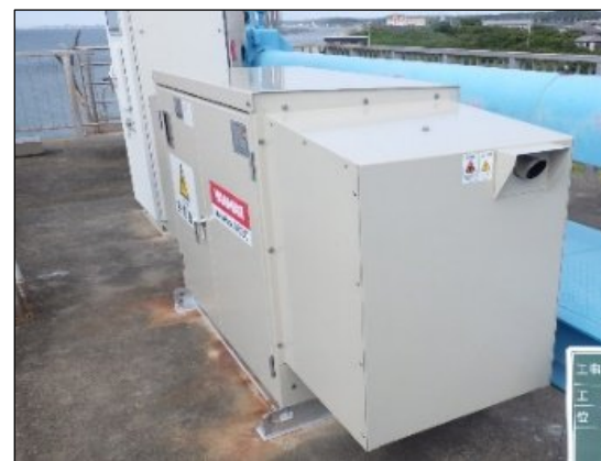
杉谷川樋門(美浜町) 老朽化対策(発電機の更新)
