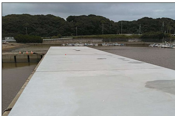
赤羽根漁港(田原市) 防波堤耐震・耐津波強化対策(L=50m完了)
