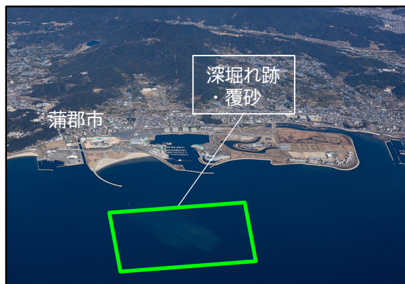
大塚地区 深掘跡の埋戻し・覆砂位置
