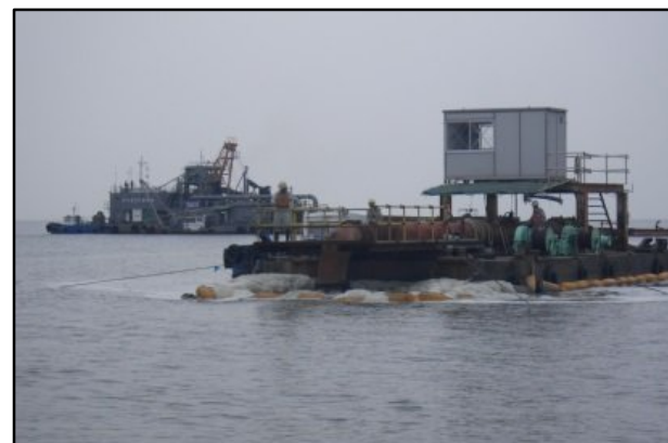
覆砂の作業状況
