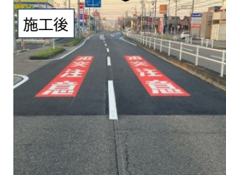
(主)名古屋江南線 カラー舗装等による速効対策
