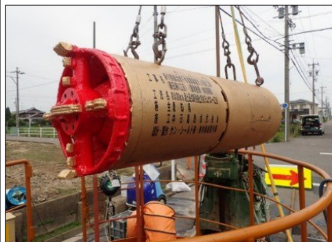
新川西部流域下水道(清須市) 管渠整備
