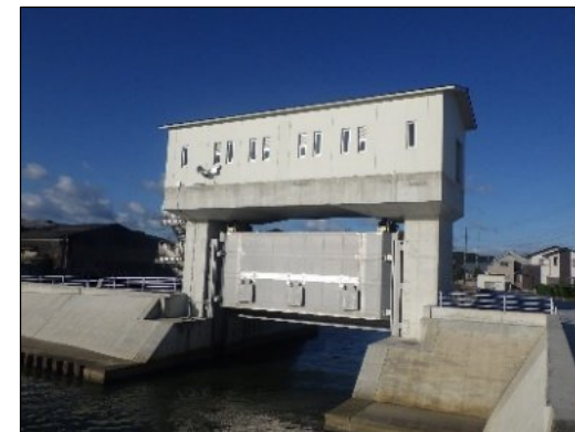
布土川樋門(美浜町) 耐震化(改築)
