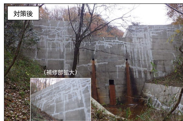
木瀬川右支川堰堤（豊田市）：堰堤のひび割れ補修
