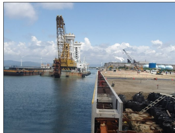
三河港田原地区(田原市) (2026年度 岸壁170m供用予定)
