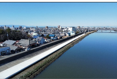
新川 堤防耐震化(名古屋市中川区)
