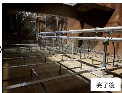
五条川左岸浄化センター(小牧市) 1-2系散気装置更新
