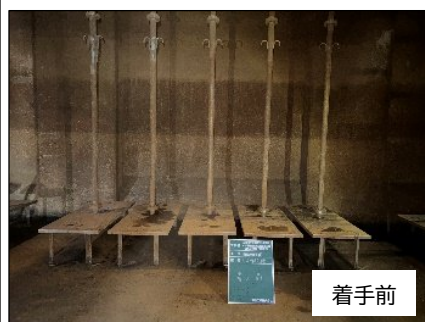
五条川左岸浄化センター(小牧市) 1-2系散気装置更新
