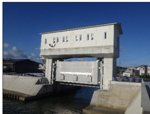
布土川樋門(美浜町) 自動閉鎖化(改築)
