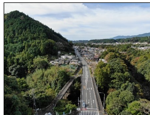
(主)豊橋乗本線(新城市) L=0.9km供用(2022年3月)
