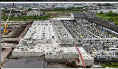
五条川右岸浄化センター水処理施設増設(岩倉市)
