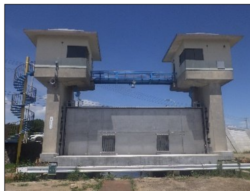
池尻川水門(田原市) 耐震化
