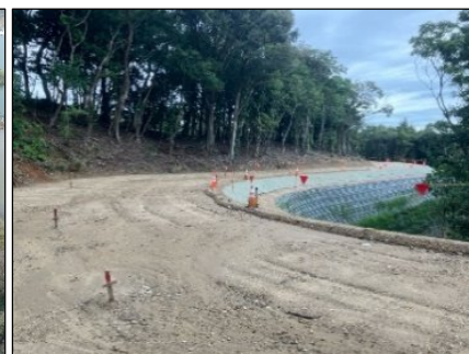
東三河ふるさと公園(豊川市) 園路整備
