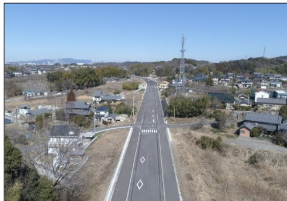
(主)岡崎足助線(岡崎市) L=1.1km供用(2023年3月)
