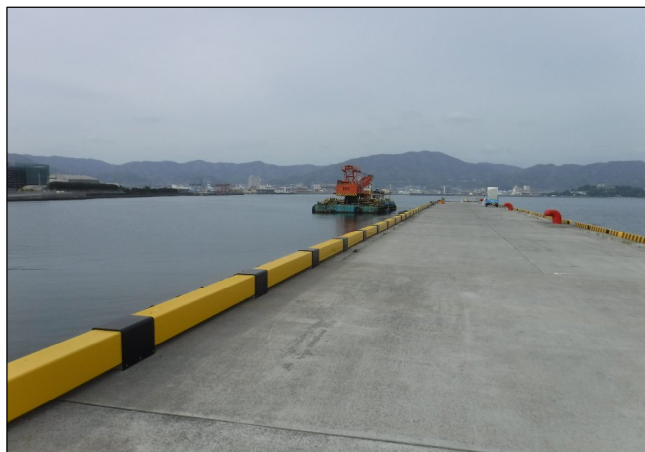
三河港蒲郡地区(蒲郡市) (2021年度 岸壁130m供用)
