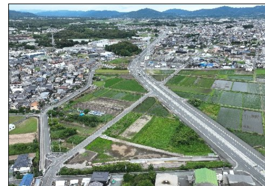
(主)東三河環状線(大崎工区)(豊川市) L=1.6km供用(2023年5月)
