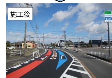
(主)一宮津島線 カラー舗装等による速効対策
