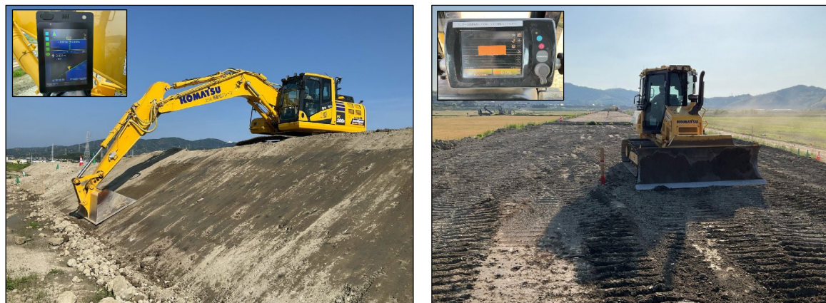
ICT建設機械による施工状況(菱池遊水地)
