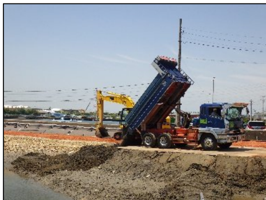
衣浦港中央ふ頭西地区(半田市) 護岸工事・埋立工事
