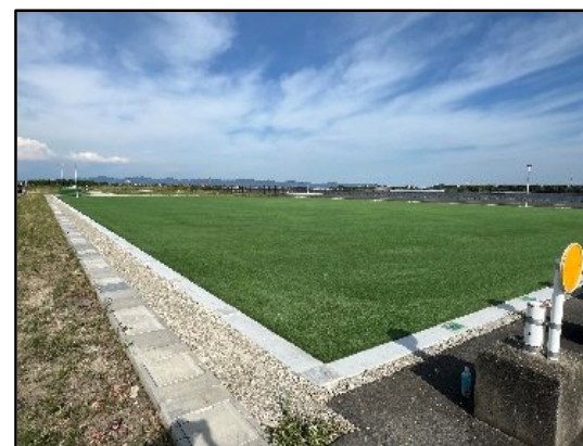
三河港 御津緑地(豊川市) 工事中
