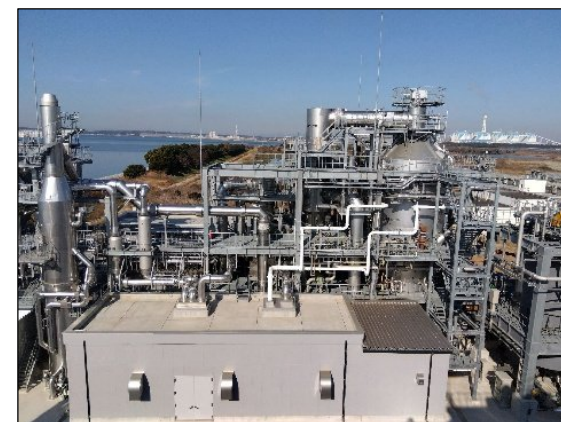
①⑤矢作川浄化センター(西尾市) 焼却炉
