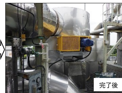
衣浦東部浄化センター(碧南市) 污泥燃料化施設熱交換器更新
