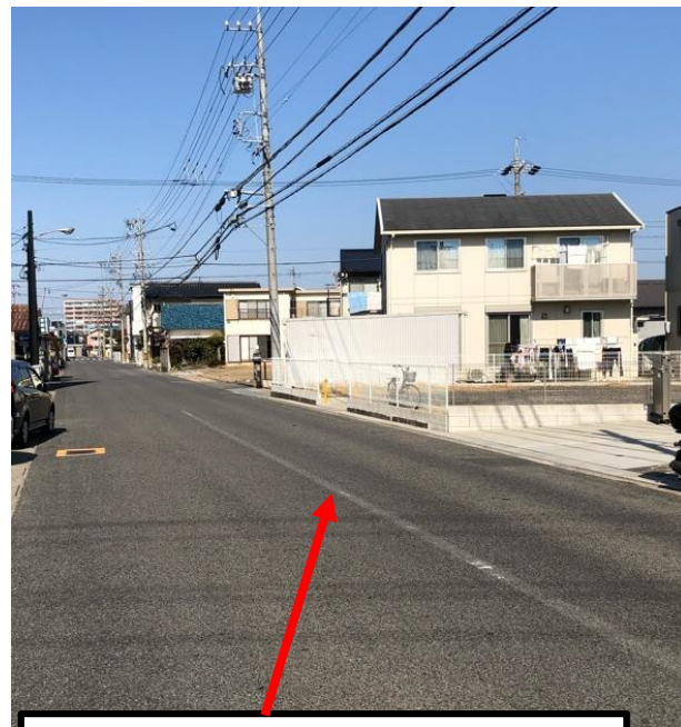
中央線を抹消し、外側線を設置。
