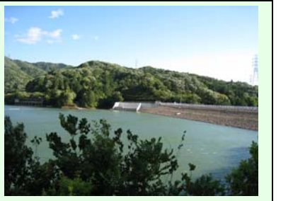
堤防の嵩上げ工事が完了した大井池
