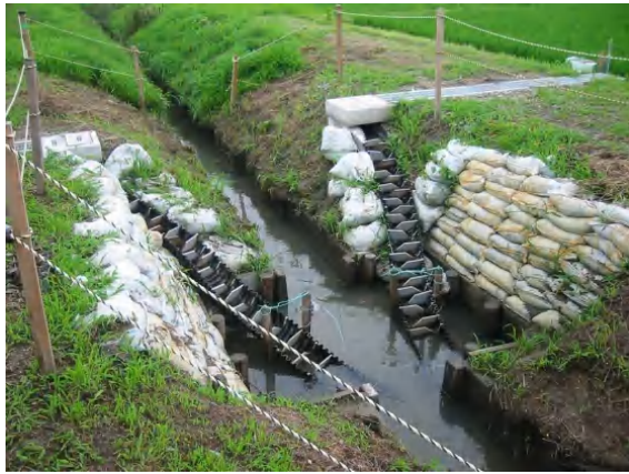
写真3 魚道の設置状況
